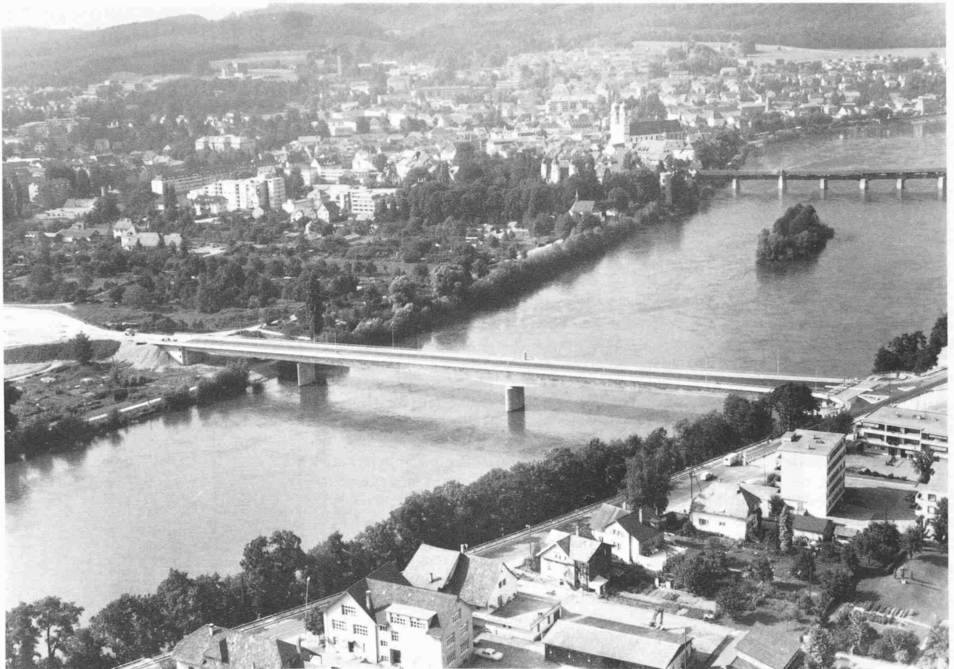
Bild 1. Flugaufnahme der vollendeten Brücke
