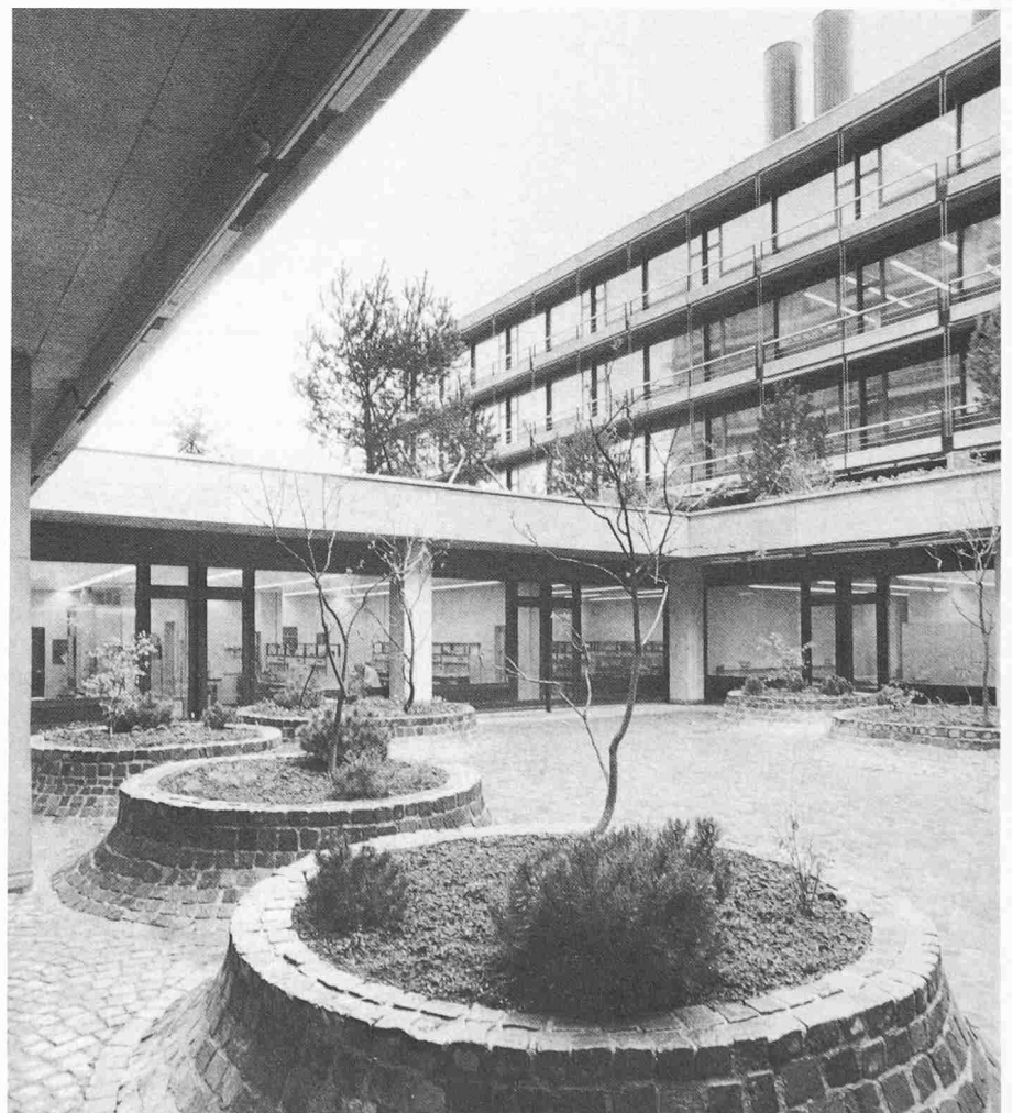
Blick in einen Innenhof zwischen den Labortrakten
