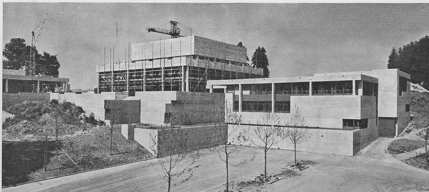
Handelshochschul-Neubau in St. Gallen. Hauptbau, rechts davor Technologie, links Aula. Bauzustand Juli 1962
