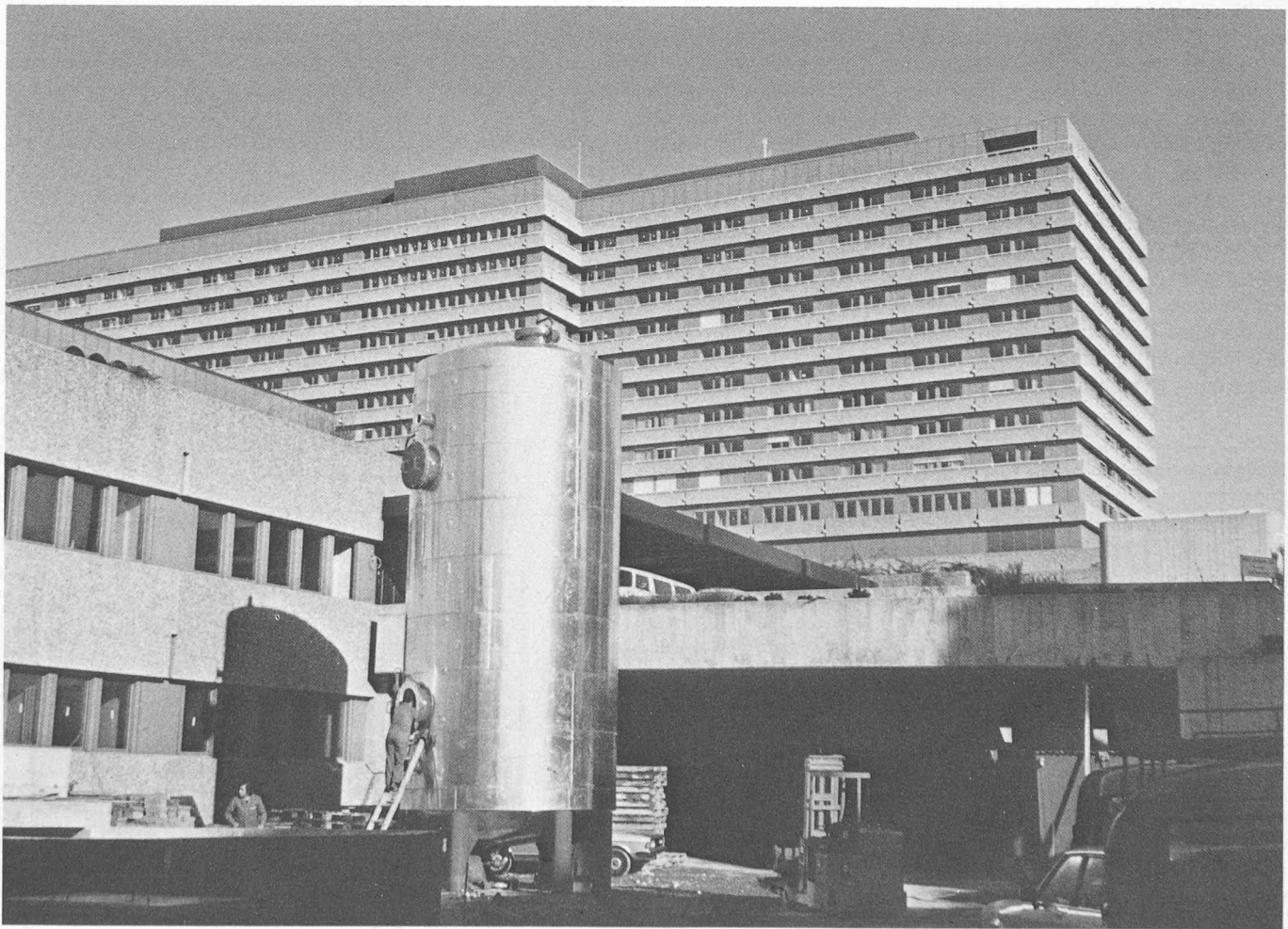
Fig. 4. — Cagnotte isolée, avant sa mise en place dans le puits.
