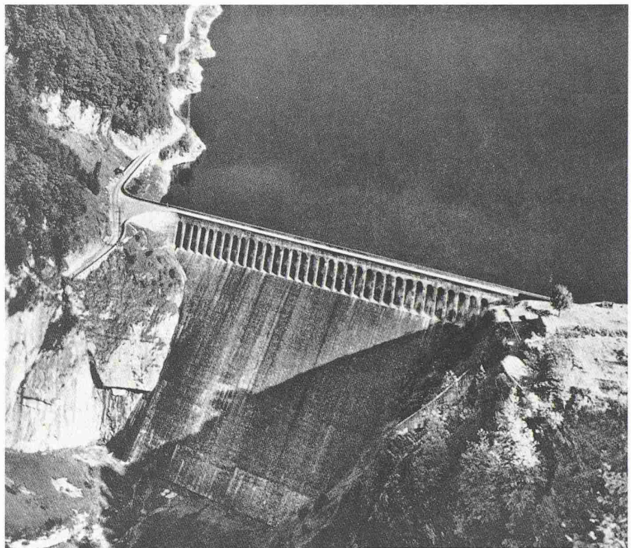
Bild 7. Ansicht der Staumauer Schräh (nach [8] S. 55)
