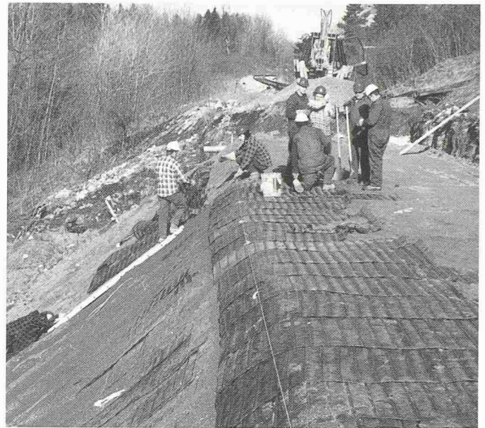
Eisenbahndamm in Ontario (Kanada), ausgeführt mit einaxialen Geogittern
