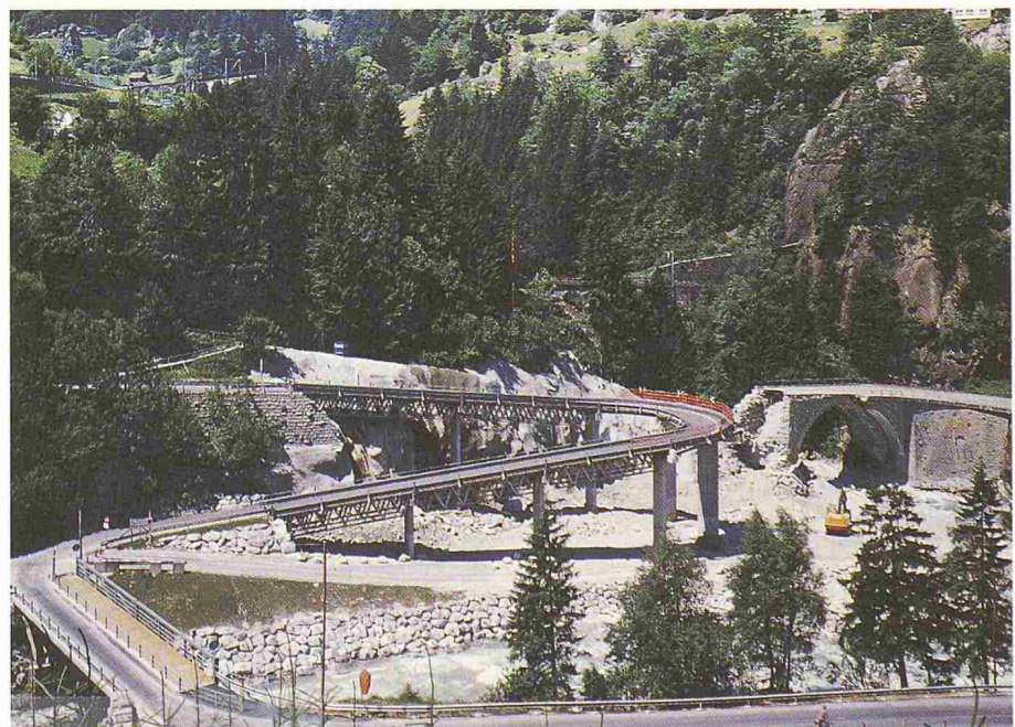
Bild 5. Provisorische Kantonsstrasse zwischen dem Pfaffensprung und Wassen (Foto Basler + Hofmann)
