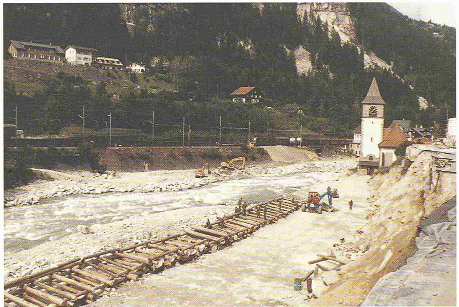
Bild 4. Kirche Gurtellen, im Vordergrund zerstörte Gotthardstrasse, Bau von Krainerwänden (Foto Bauamt Uri)
