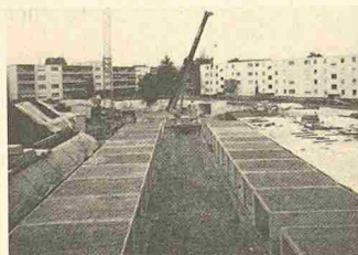
Frisba-Tiefgarage in Volketswil
