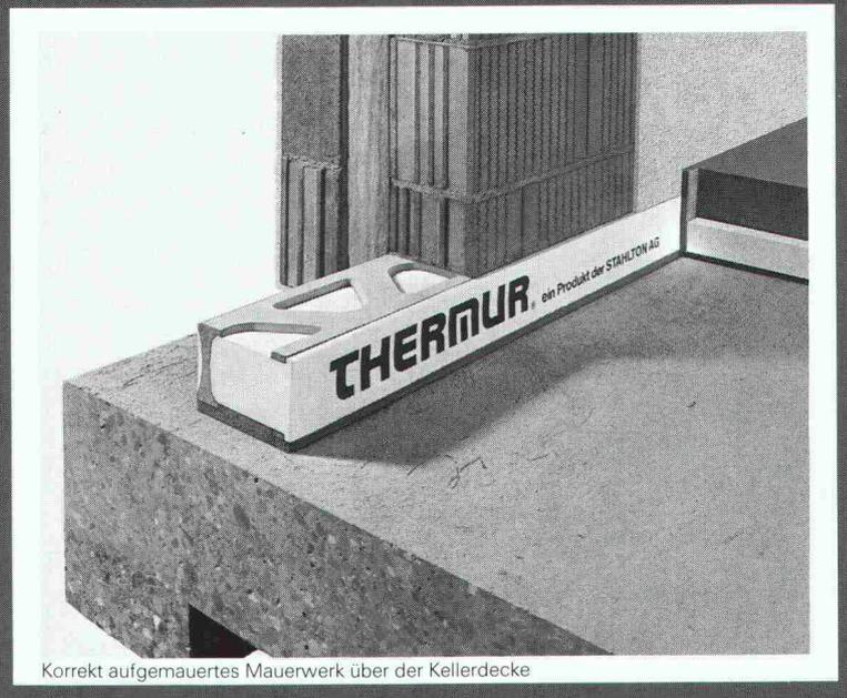
Korrekt aufgemauertes Mauerwerk über der Kellerdecke
