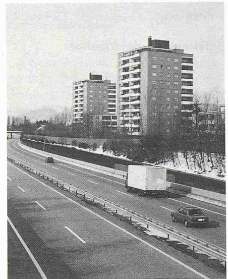
An derartiger Wohnlage sind Schallschutzmassnahmen am Gebäude, und hier vor allem im Fensterbereich, dringend
