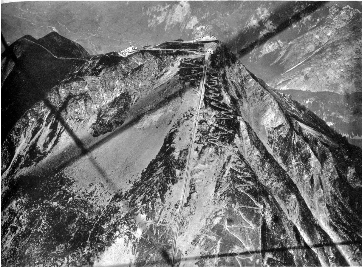
Niesen-Kulm mit Bahntracé 2300 Meter
