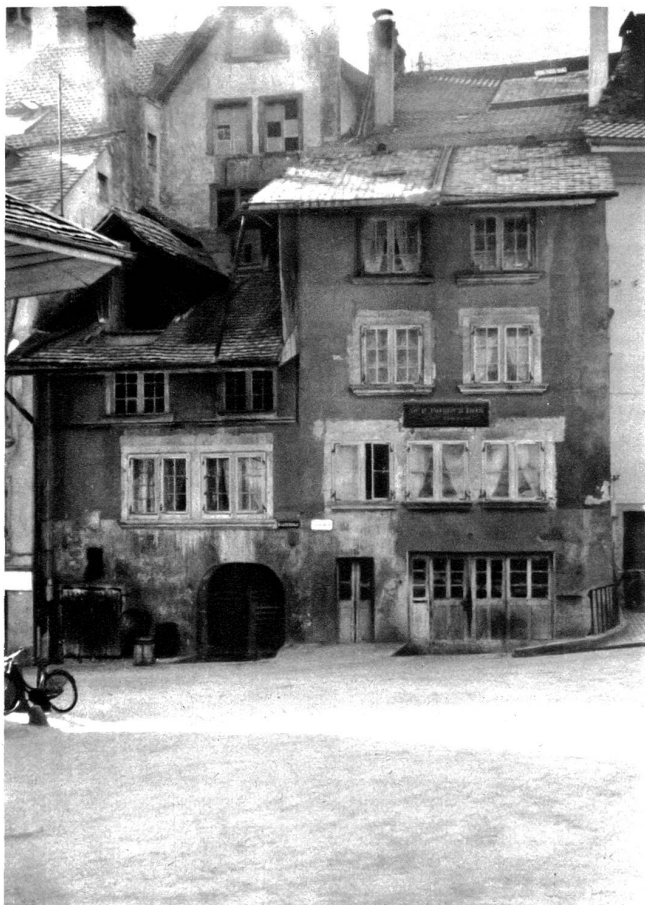
Der „Burger Hus“ mit der alten Schmiede. Darüber sind Häuschen des Nydegghöflis sichtbar
