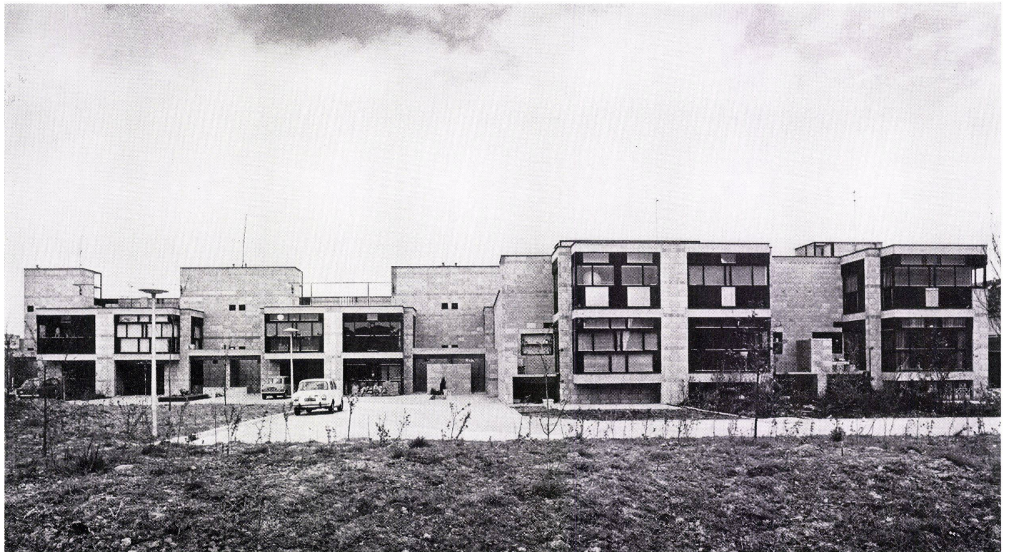
14 Gesamtansicht, Erschließungsseite. Vue générale côté accès. Assembly view, access side.
