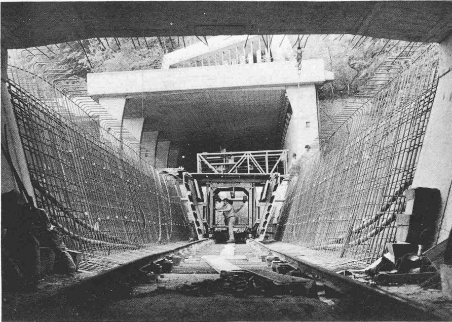
Lehnenviadukt Beckenried. Stand der Bauarbeiten: Mitte Mai 80. Schalung und armieren des letzten Brückenfeldes vor dem Nordportal des Seelisbergtunnels
