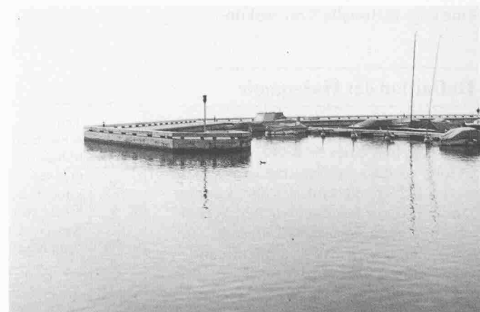
Bild 5. Hafenanlage in Zug, Ausbildung als Schwimmole
