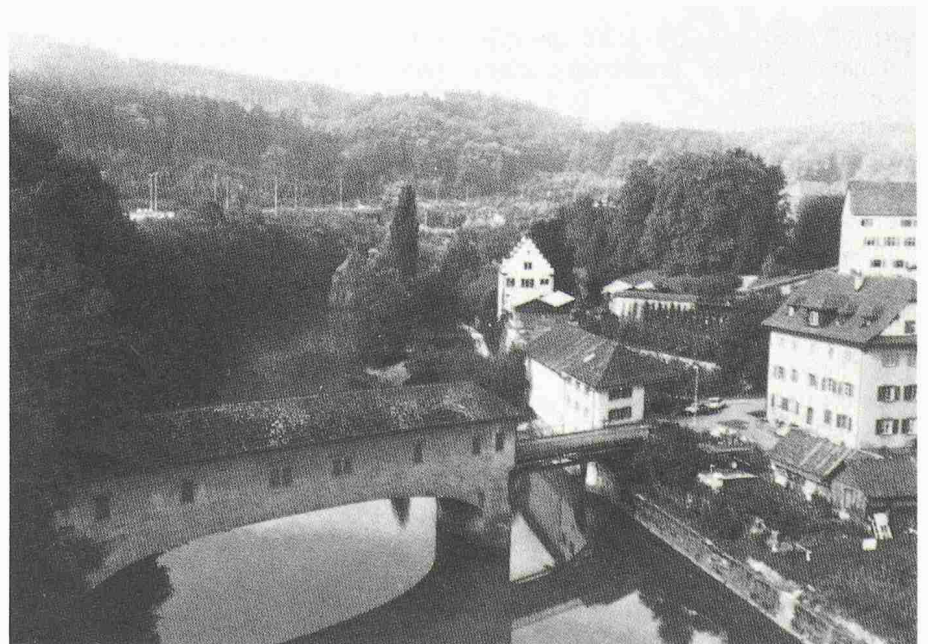
Beispiel Spezialfall (Limmthalbinsel von Wettingen): Neben der Klosteranlage aus dem 13. und 17. Jh. steht die alte Spinnerei aus der 2. Hälfte des 19. Jh. Zum Ensemble gehören einige wenig später entstandene Wohnbauten und die gedeckte Holzbrücke von 1818 (Bilder: ISOS)
