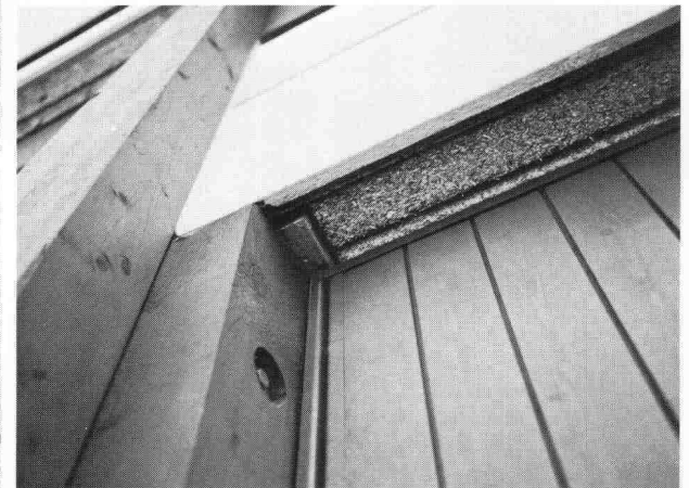
Detail Mehrzweckhalle, Haag SG
