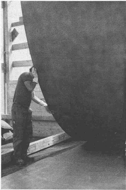
Bild 13. Aufkleben von 8 m 2 grossen Stahlblechen als Strahlenschutz für die Steuerorgane des Zonenpumpwerkes Hardhof in Zürich
