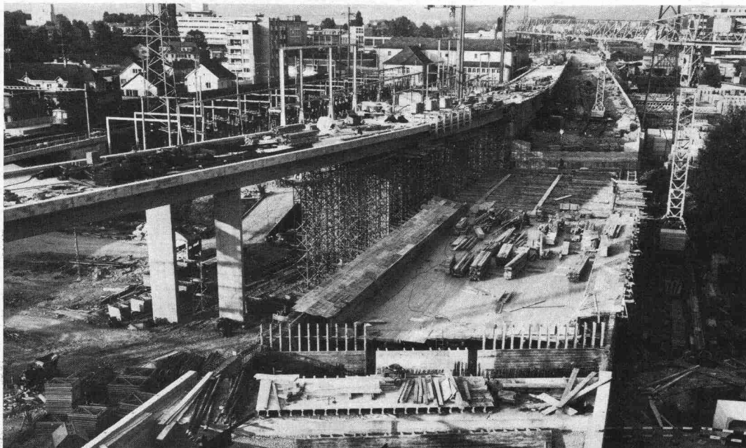
Brücke über die Glattalstrasse, Bauwerke: rechts BW 211, links BW 212
