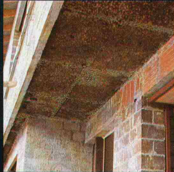
Kork in die Schalung gelegt
