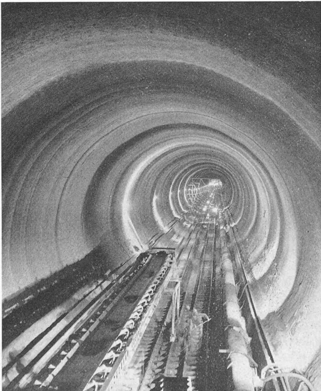
Bild 1. Heitersbergtunnel (Los Ost): Fräsvortrieb, Spritzbetonverkleidung
