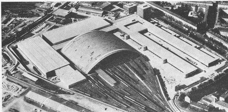
Bild 8. Paketumschlaghalle München, Zweigelenkbogenfaltwerk mit  $150 \text{ m}$  Spannweite
