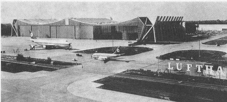
Bild 16. Wartungshalle V, Frankfurt, zweischiffiges erdverankertes Hängedach aus Spannleichtbeton mit  $2 \times 130$  m Spannweite. Grundfläche:  $270 \times 100$  m, lichte Höhe: 22 m, Torlänge: 270 m
