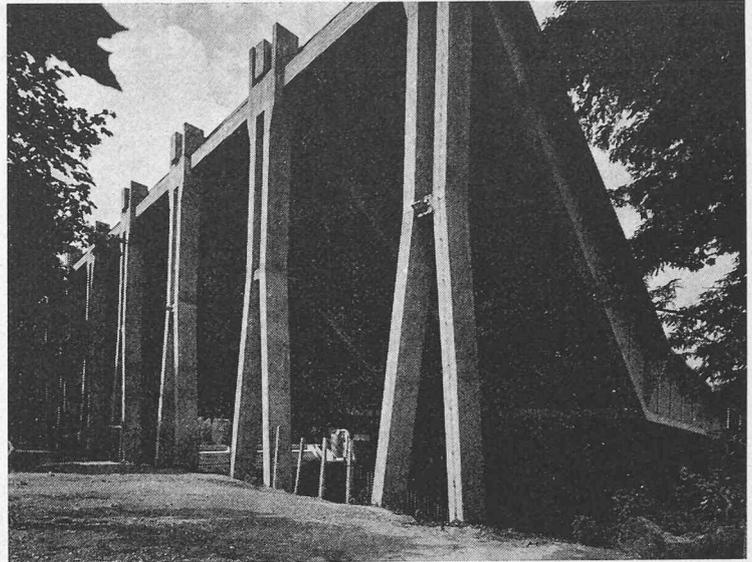
Bild 1 (links). Paketumschlaghalle München, Zweigelenbogenfaltwerk mit 150 m Spannweite über einer Grundfläche von  $124 \times 150$  m. Die Faltung der tragenden Fläche beherrscht den Innenraum. Der Blick geht von Bogenkämpfer zu Bogenkämpfer. Das Fertigteilbecken im Vordergrund ist eines von 27, die das Niederschlagwasser entlang jeder Kämpferlinie aufnehmen
