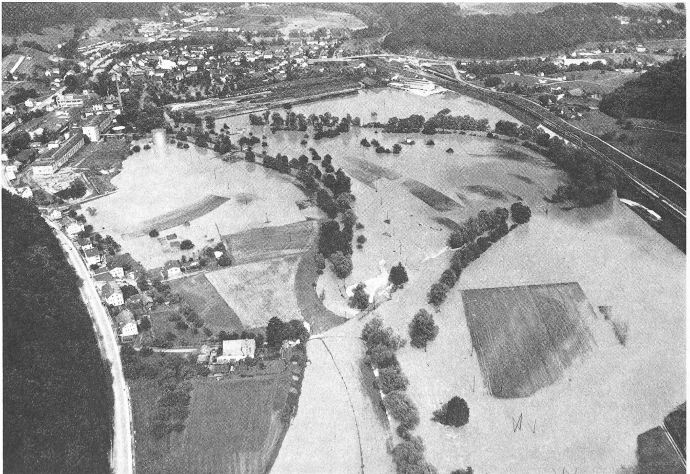
Bild 1. Birshochwasser vom 23. Juni 1973 in Zwingen
