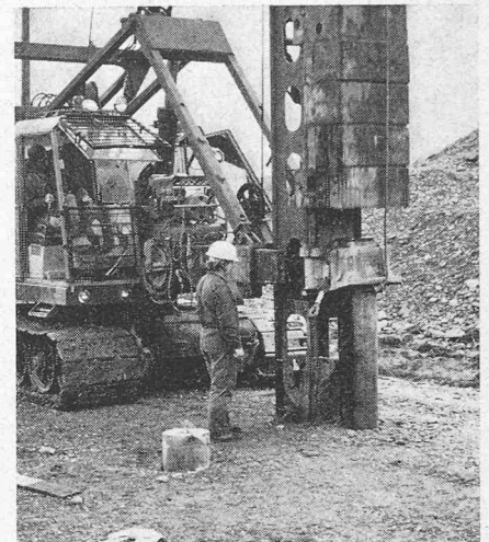
Bild 8. Rammern der Pfähle
