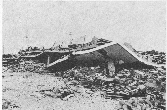
Bild 12 (nach dem 6. Mai). Links: Wohnhaus mit Verkaufslokal bei Artegna. Stahlbetonskelettbau mit Backsteinfüllwänden in den zwei Obergeschossen, im dreiseitig offenen Erdgeschoss sind nur die hintere Längswand und das Treppenhaus ausgefacht. Die Zerstörungen sind auf das Erdgeschoss konzentriert, in dem eine Drehbewegung um den Treppenhaukern mit rund 40 cm Maximalverschiebung auftrat. Die Backsteinwände des Treppenhauses wurden stark zerstört, diejenigen des Obergeschosses blieben unbeschädigt
