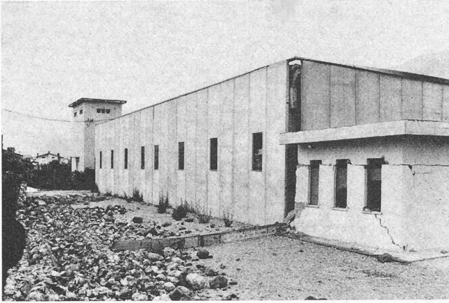
Bild 8 (nach dem 6. Mai). Links: Vorfabrizierte Halle mit Backsteinanbau in Gemona. Das Tragskelett der Halle ist unbeschädigt, dagegen wurden die Betonelemente der Seitenwand beim Aufprall an den steifen Anbau leicht eingedrückt. Die Kunststoffmasse der Wandfugen wurde infolge der grossen Verformungen zerrissen. Das Dach des Anbaues ist durch die Impulsbelastung des Anpralls infolge ungenügenden Bauwerkabstandes auf Fensterhöhe abgesichert und weggeschoben worden
