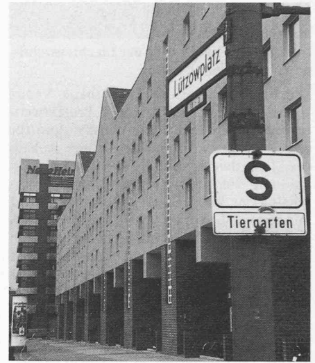
Lützowplatz West, Strassenfront
