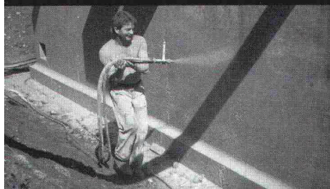
Starre Rascolit-Abdichtung an einer Tiefgarage gegen Grund- und Meteorwasser.
