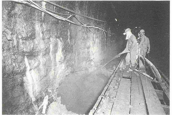
Bild 5. Zuspritzen einer Widerlagerunterfangung mit Spritzbeton
