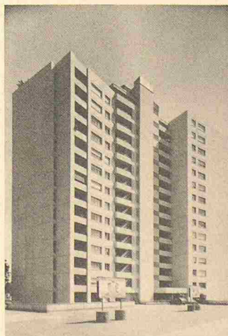
Das Ende sechziger Jahre von Alvar Aalto erbaute Hochhaus Schönbühl in Luzern wurde wärmetechnisch saniert und mit Armafил-Elementen verkleidet
