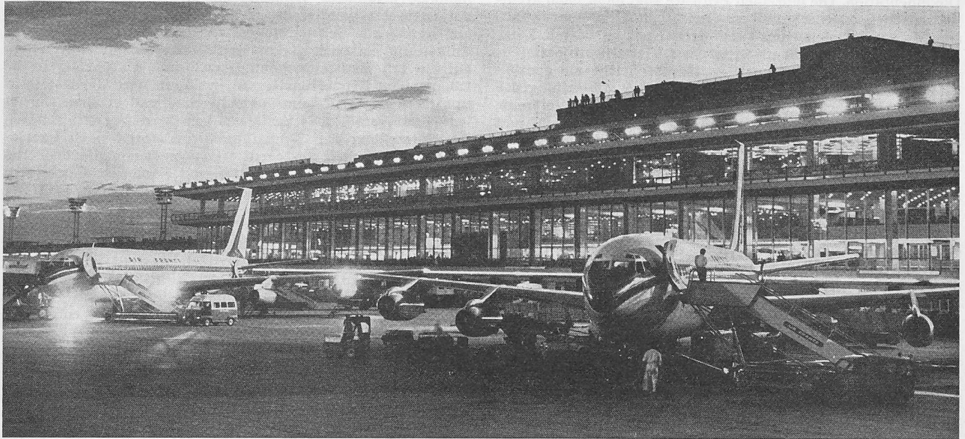
Flughof Orly, Ansicht des Westflügels von Süden
