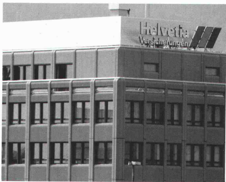
Geschäftshaus Helvetia-Unfall Zürich
