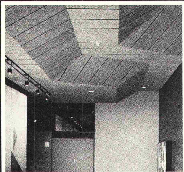
Mensa-Mehrzweckhalle ETH Zürich
