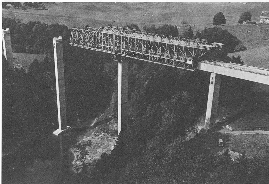
Bild 6. Viaduc du lac de la Gruyère. Vorschubgerüst Viaduct of Gruyère. Launching beam
