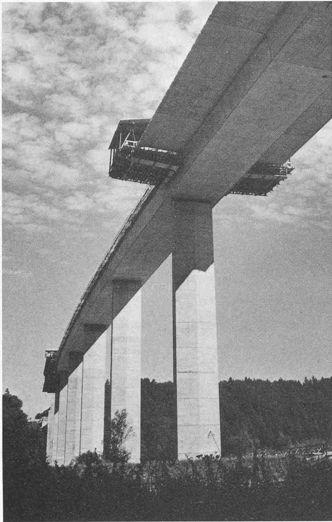
Bild 7. Saaneviadukt Gümmenen. Betonieren der weit auskragenden Fahrbahnplatte mit Hilfe eines Schalungswagens Saaneviadukt Gümmenen. Concreting of large lateral overhangs with the help of a moving cart
