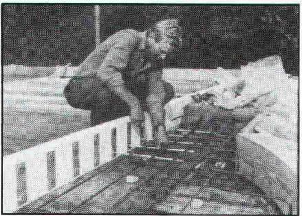
Mit wenigen Handgriffen sind die Armierungsstäbe eingeschoben und bereit für den Anschluss.
