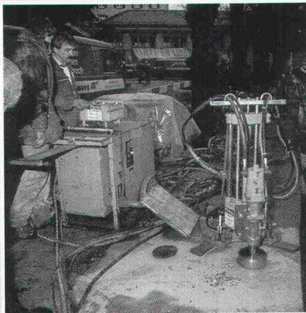
Der Abbruch von Betonteilen mit extrem grossen Ausmassen wird aus wirtschaftlichen Gründen durch Perforationsbohrungen oder mit hydraulischen Sprengeräten ausgeführt.
