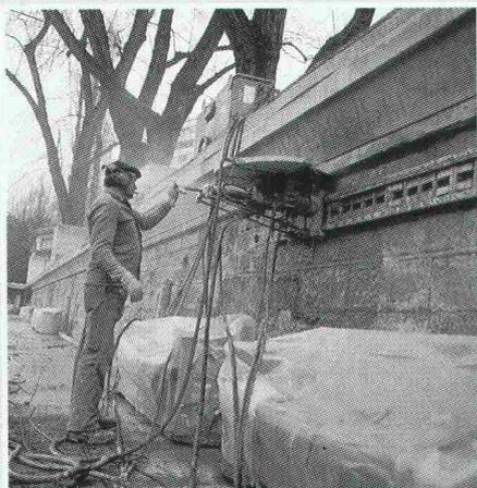
Die aufliegende Betonkonstruktion muss abgebrochen werden. Um das als Auflage dienende, unter Heimat- und Naturschutz stehende Sandsteinmauerwerk nicht zu beschädigen, wird mit einer Diamantsäge horizontal ein Trennschnitt erstellt.
