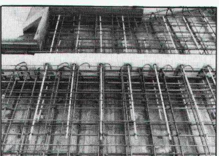
Ohne Schalungsdurchdringung. Kraftschlüssig gegen Quer-, Zug- und Druckkräfte.
