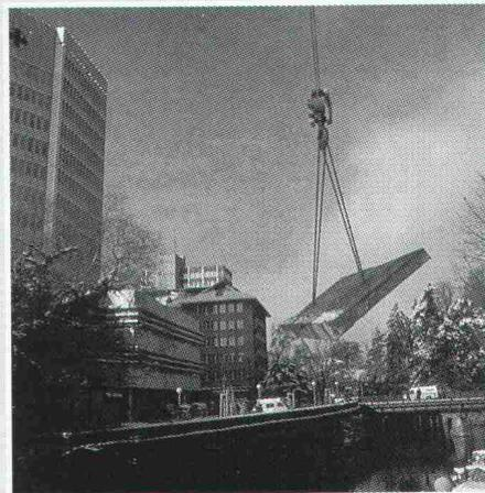
Mehr und mehr gehören solche Szenen zum täglichen Bild der modernen Bauindustrie. Mit Diamantwerkzeugen sauber geschnittene Abbruchelemente werden mühelos und ohne belastende Emissionen entfernt.
