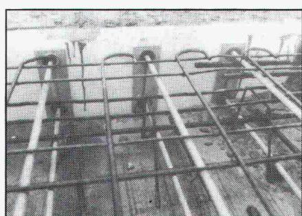
Betonmilch mit Feinteilen umschliesst nur die feuerverzinkten Stäbe korrosionsfrei. (2-facher Korr.-Schut.)
