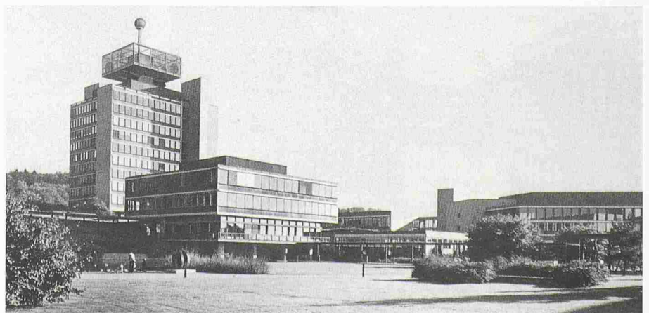
Blick aus einem Gartenhof auf die Unterrichtsbauten v.l. Praktikumbäude mit Antennenanlage, Zentralgebäude, Studentenrestaurant, kleines und grosses Hörsaalgebäude
