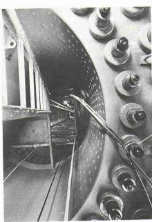
Ein Blick ins Innere des 130 m hohen Stahlrohrmastes, der die Antennen des neuen Fernsehturms tragen wird
