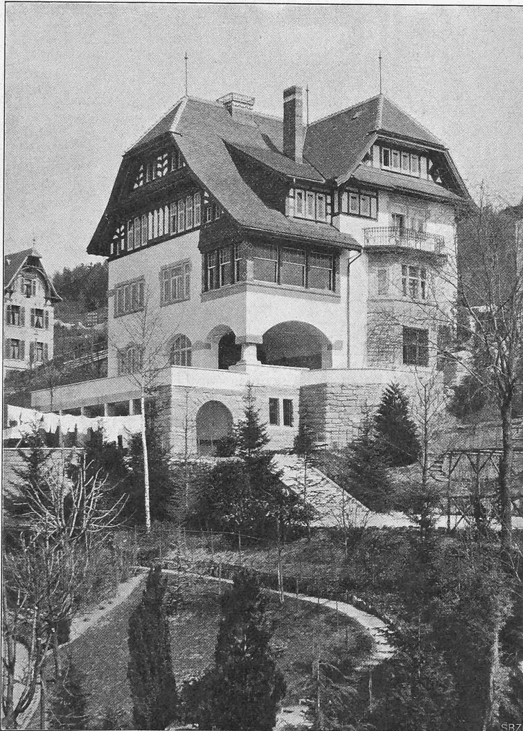
Abb. 8. Die Villa «Hadlaub» an der Rigistrasse in Zürich IV. — Gartenansicht. Erbaut von den Architekten Pflegard & Haefeli in Zürich.
