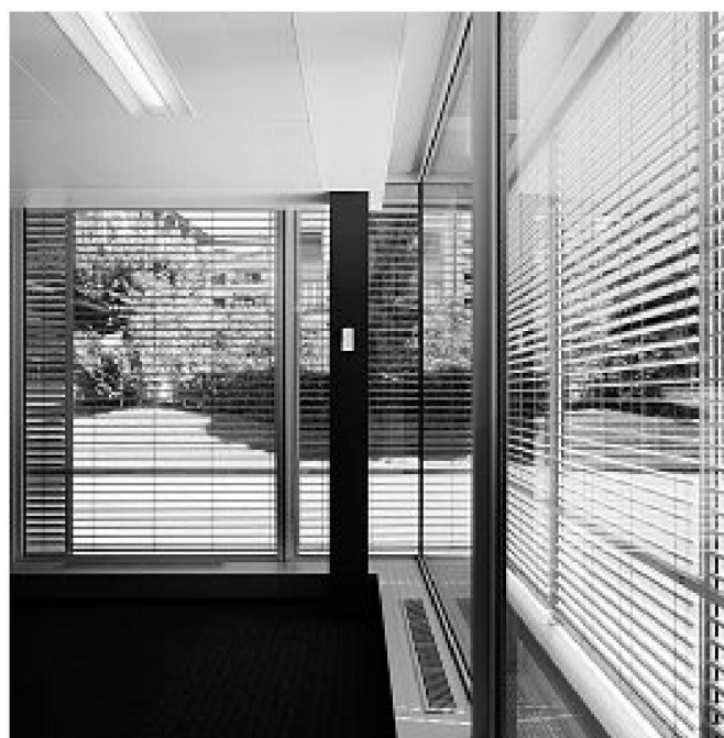
Intérieur du bureau avec façade double
