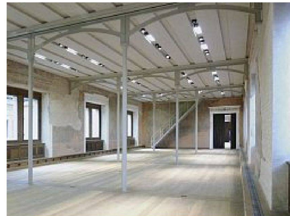
Neue Eisenstützen in den Sälen des 2. Obergeschosses. – Bild: Christian Raabe
