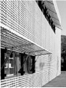
Klappläden an der Fassade
