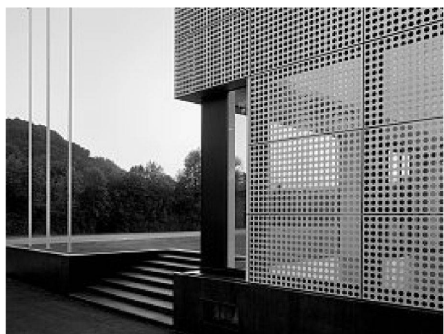
Eloxierte Lochbleche bilden die dünne Fassadenhaut.
