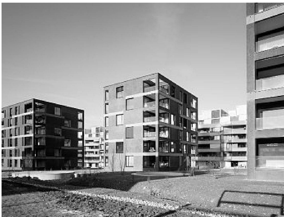
Punkthäuser, im Hintergrund das Langhaus
