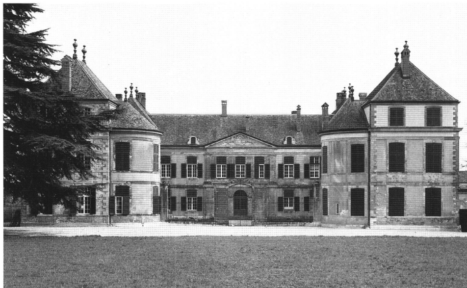
Fig. 1 Le château de Coppet. Vue de la cour d'honneur depuis les jardins. A droite, l'extrémité de l'aile sud, de 1665 environ, englobant à moitié une ancienne tour médiévale qui sera reconstruite partiellement vers 1702. A gauche, le corps de logis et l'aile nord avec sa nouvelle demi-tour, édifiés entre 1715 et 1725.
