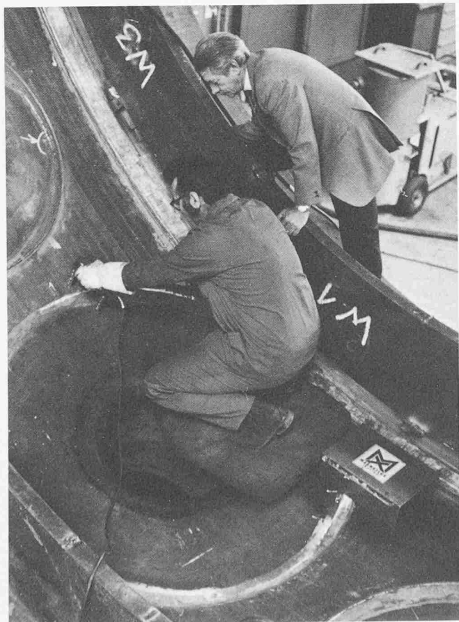
Bild 14. Oberflächenrissprüfung mit dem Jochmagnetisierungsgerät im Bereich eines Kühlmittelstutzens des Reaktor-Druckbehälters Leibstadt. Überwachung der Arbeit durch einen Sachverständigen der SVDB
