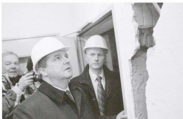
Fig. 4: Gebäudeschäden in Staufen D, verursacht durch Anhydrit-Gips-Umwandlung und starker Quellung. Es besteht kein Zusammenhang mit Geothermie-spezifischen Methoden. Ähnliche Schäden hätten bei Grundwasserbohrungen, Baugrunduntersuchungen oder beim Tunnelbau entstehen können. Quelle: Webbilder zu Staufen «Geothermie-Schäden».
