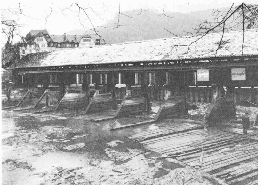
Zustand der Schleuse unmittelbar nach der Trockenlegung
