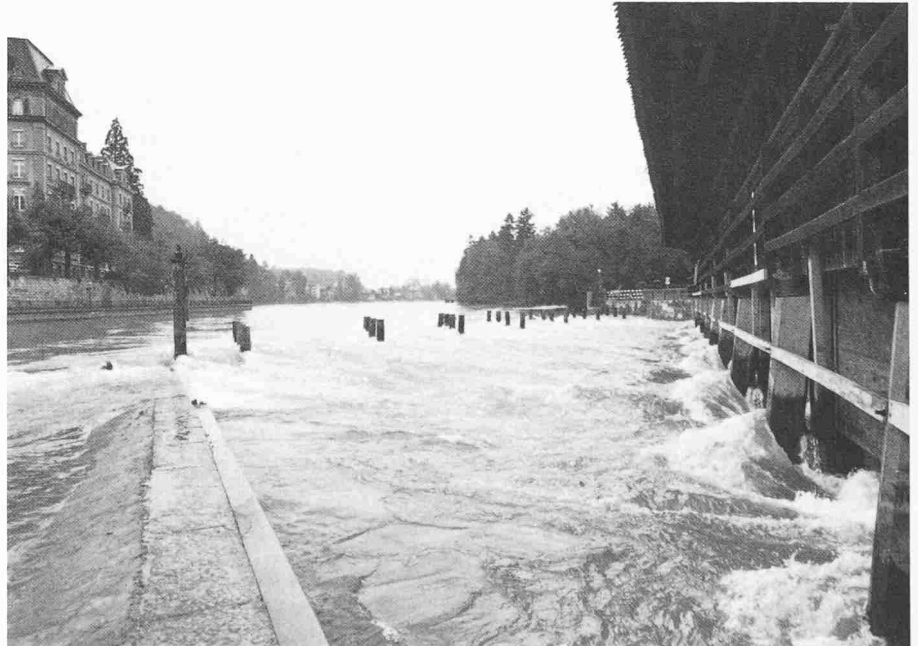
Blick flussaufwärts vom Bälliz-Zinggen. Die Pfähle der Hilfsbrücke konnten erst später entfernt werden
