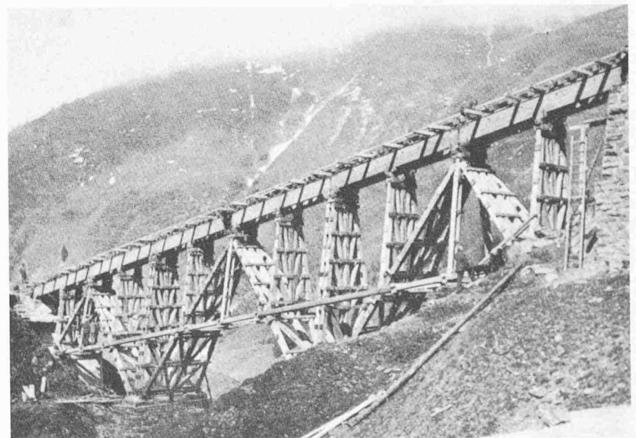
Bild 27. Kühmattobel-Brücke der Brienzer-Rothorn-Bahn, 1942, mit harnstoffharz-verleimten, fast ungeschützten Hauptträgern. Die nach rund 25 Jahren ersetzte Konstruktion wurde jeweils im Winter wegen der Lawenniedergänge demontiert und deponiert. Projekt F. Hübner und M. Cosandey, Lausanne. Holzbauunternehmung Fietz & Leuthold AG, Zürich [22/33]
