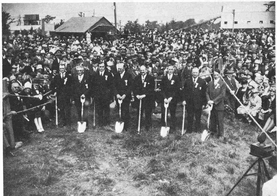
Bild 8. 1. Spatenstich der George Washington Bridge 21. September 1927 (rechts aussen O. H. Ammann)
