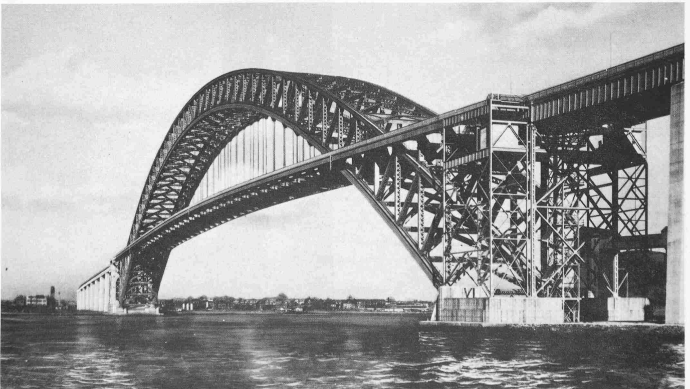
Bild 10. Bayonne Bridge eröffnet 15. November 1931
