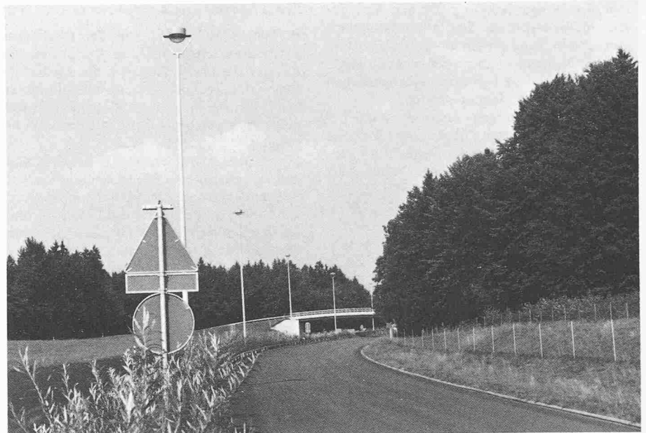
Bild 3. Beleuchtung entlang der Autobahn, Lichtpunkthöhe 15 m, Lichtpunktstand 60 m
