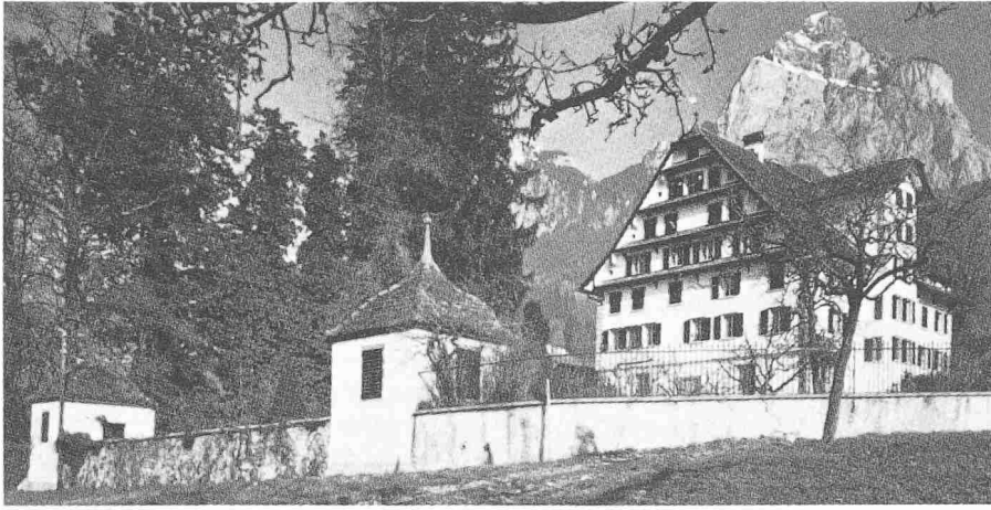
Schwyz, Waldegg (ehemaliger Murghof), 1600. Das südöstlich des Fleckens gelegene Haus von längsrechteckigem Grundriss mit durchgehendem Mittelgang folgt im Aufriss dem Typus des herrschaftlichen Bauernhauses mit steilem Giebel. Das Erdgeschoss ist massiv gemauert, die oberen Stockwerke sind in Blockbauweise ausgeführt
