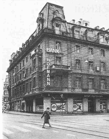
Blick von Nordosten
